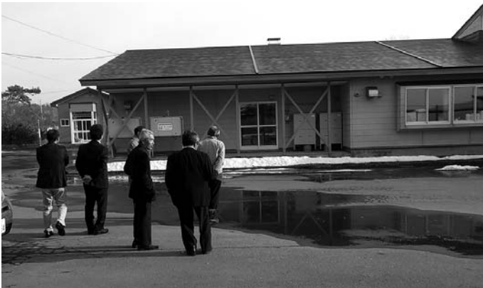
「三ノ原五輪会館屋根改修工事」の状況視察 (総務・民生常任委員会、産業・建設常任委員会)
